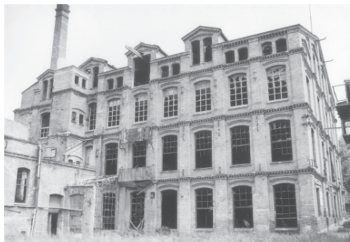
Figura 10 Estado de la fachada interior (patio) del edificio principal de Ca l'Aranyó, 1996. (Fotografía: Antoni Vilanova)
