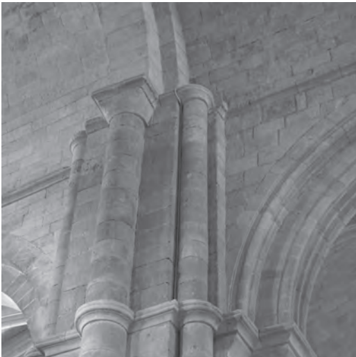
Figura 6 Detalle de soporte de la nave central de la colegiata de Toro (Zamora), imagen de los autores
