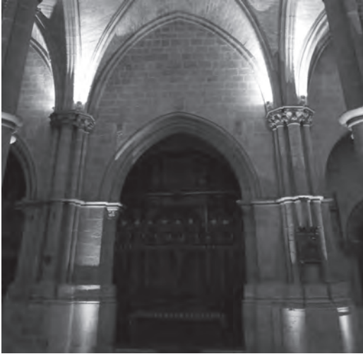
Figura 10 Vista del muro de la nave lateral de la catedral de El Burgo de Osma (Soria), imagen de los autores
