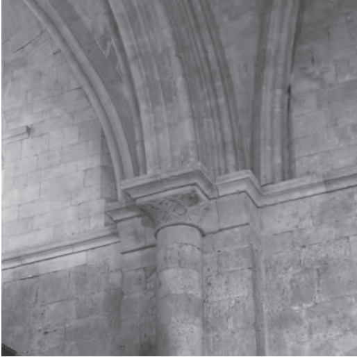
Figura 5 Detalle del encaje de nervios ojivos en el muro de la nave lateral de la colegiata de Toro (Zamora), imagen de los autores
