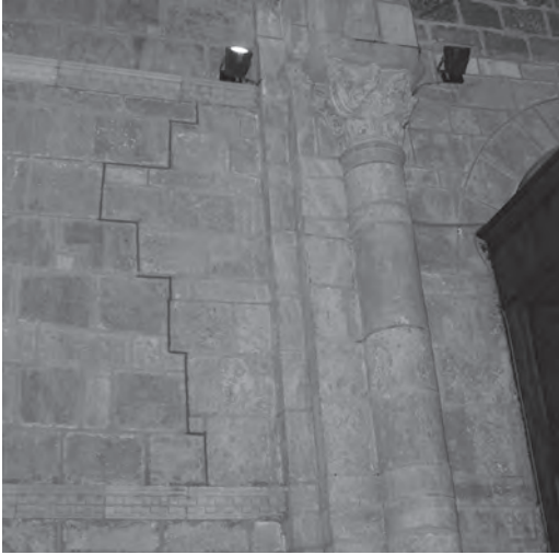
Figura 3 Detalle de soporte sobre vano en la nave lateral norte de la Real Colegiata de San Isidoro (León), imagen de los autores
