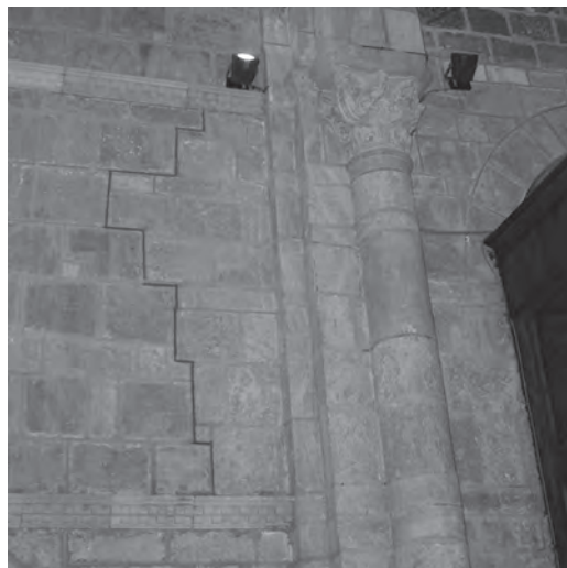
Figura 2 Detalle de solución de continuidad entre etapas de obra de la Real Colegiata de San Isidoro (León), imagen de los autores
