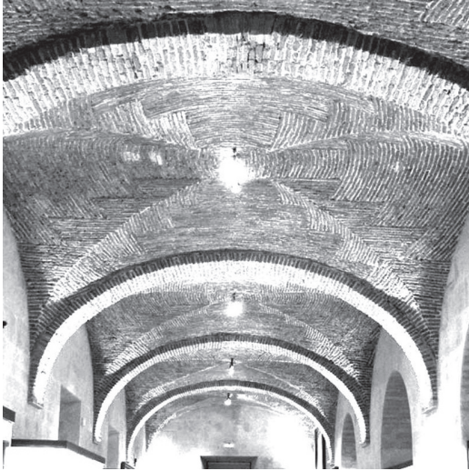
Figura 1 Antigua hospital de Santa María en Plasencia (López Romero 2015)
