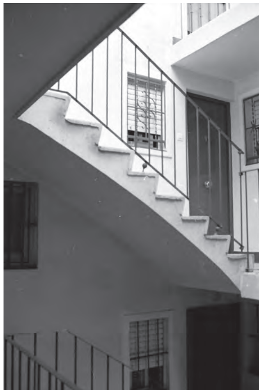
Figura 10 Viviendas experimentales en Villaverde. Bóveda tabicada del núcleo de escalera en patios. Fotografía de los autores en 1992. (Rodríguez García y Hernando de la Cuerda 2000b)
