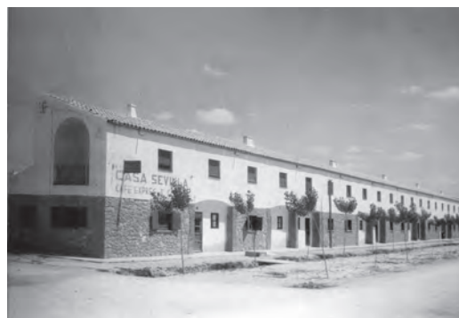
Figura 4 Grupo de Viviendas en Quintanar de la Orden, Toledo, construidas con contrafuertes integrados en la edificación (Bergera 2005b, 62)
