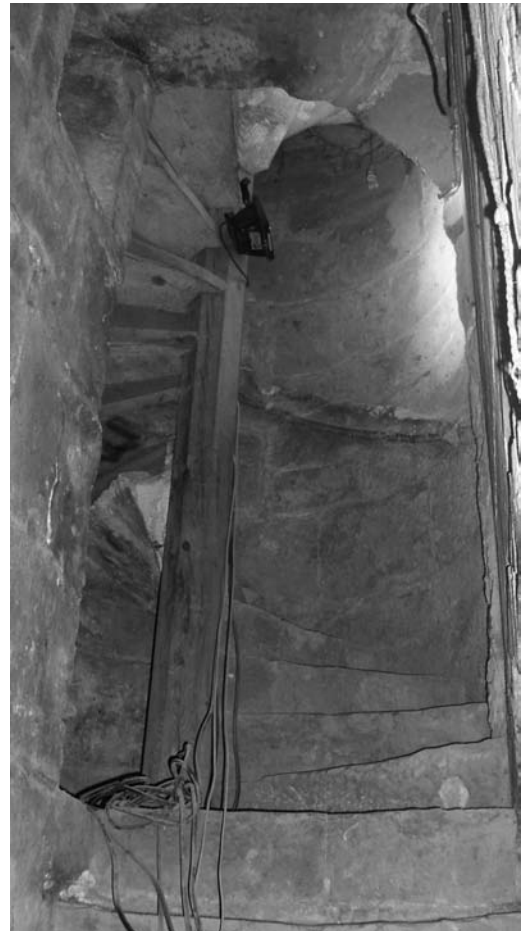
Figura 3 Escalera de caracol con ojo: final del tramo recto, arranque de fábrica y caracol de madera de carácter provisional(foto de la autora 2012)
