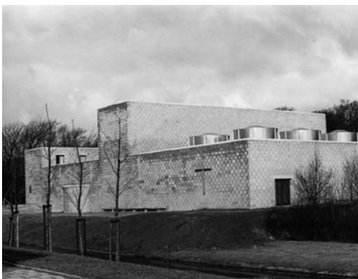
Figura 1 Fotografía exterior de la iglesia poco después de finalizadas las obras de construcción (© Aldo van Eyck Archive)
