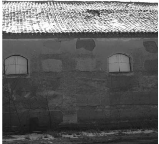
Figura 2 Exterior de la Nave de la Viesca en un estado previo a su restauración (foto del autor 2005)
