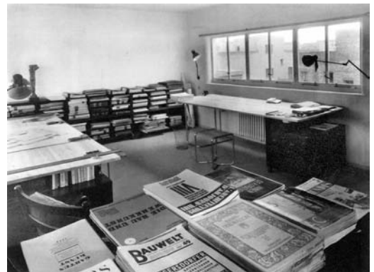
Figura 2 Estudio de arquitectura de Mercadal en la Colonia Parque Residencia, Madrid 1932. Fotografía Oples (Granell 2008, 172)
