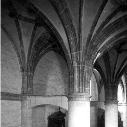
Figura 11 Arranque de los nervios sobre los pilares (foto de los autores 2013)
