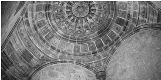
Figura 4 Bóveda baída en la sacristía vieja (foto de los autores 2012)
