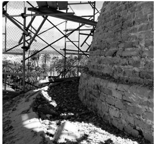
Figura 9 Arranque de la cúpula a rosca con ladrillos a tizón (Archivo Parroquial de San Juan Bautista de Cox 1990)
