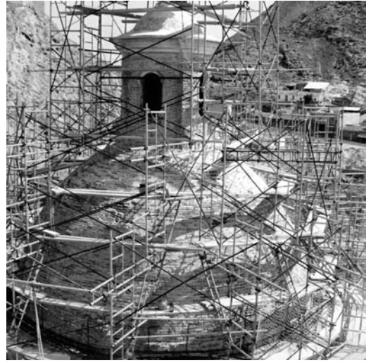
Figura 11 Linterna con nervios resistentes exteriores (Archivo Parroquial de San Juan Bautista de Cox 1990)
