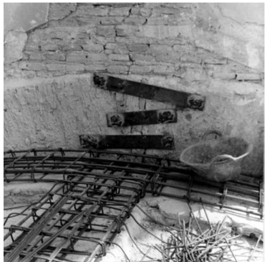
Figura 4 Construcción del anillo (Archivo Parroquial de San Juan Bautista de Cox 1990)
