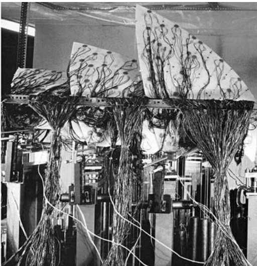
Figuras 7 y 8 Modelo a escala para el análisis estructural de las cubiertas de la Ópera de Sídney (Watson 2006)
