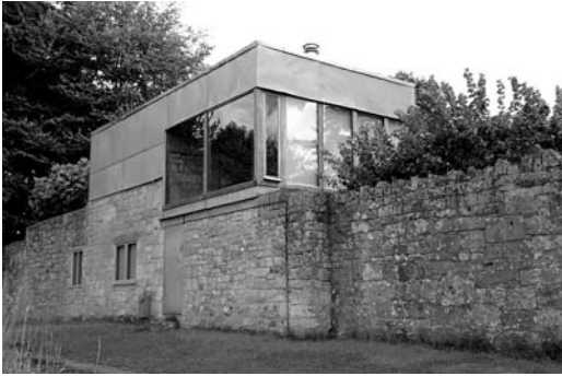
Figura 11 Upper Lawn en agosto de 2010. Variación en el módulo coincidente con el espesor del muro de mampostería de piedra (foto de la autora)
