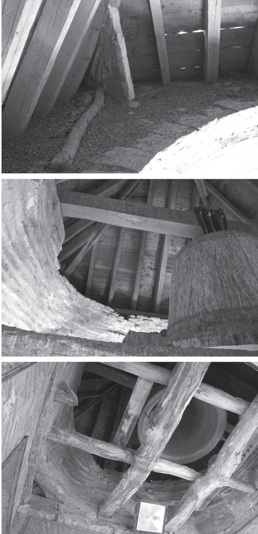
Figura 3 Fotografías de restos del arranque del tambor de ladrillo en el interior de la torre de la iglesia parroquial de Simancas en la actualidad.
