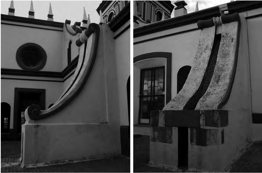
Figura 2 Contrafuertes de la nave lateral lados norte y sur (Molero 2008)
