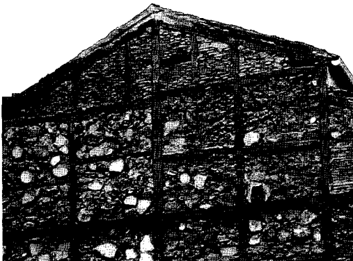
Figure 9 Timber-framed partywall or «telar de medianería». C/ Ventura de la Vega
