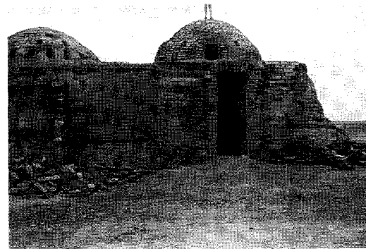
Figura 9 Fotografía antigua de los hornos en la que se puede apreciar la puerta para introducir las piezas cerámicas y el cierre calado de la parte superior.
