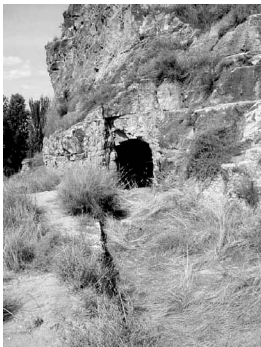
Figura 6 Detalle de la entrada en túnel del canal que discurre por la margen derecha del cañón del Huerva. En este punto se sitúa a unos 10 m sobre la coronación de la presa de Muel
