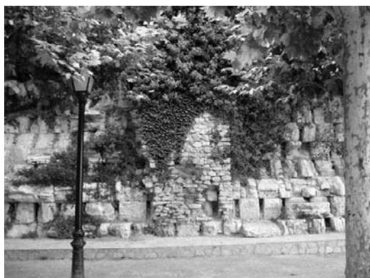
Figura 4 Presa de Muel: detalle de la zona del «contrafuerte» de refuerzo del paramento de la presa
