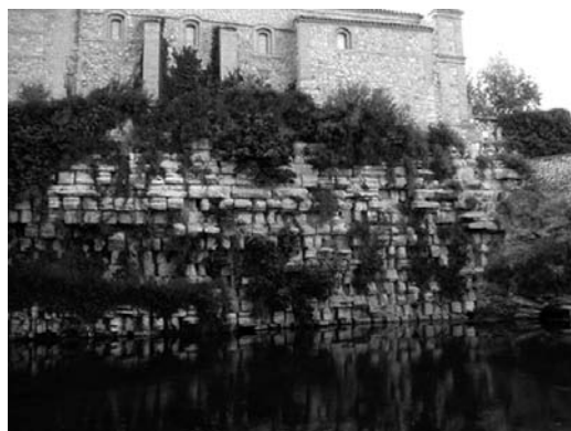
Figura 5 Estribo izquierdo de la presa de Muel, desde aguas abajo. A la derecha puede observarse la salida de la galería
