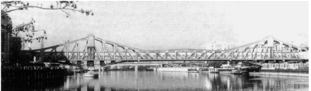
Figura 7 Pasarela de Ivry. París, 1930. (Fernández Troyano 1999)
