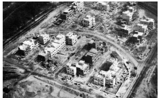
Figura 6 La colonia Parque Residencia en construcción. Revista Viviendas: revista del hogar n° 8. Febrero 1933
