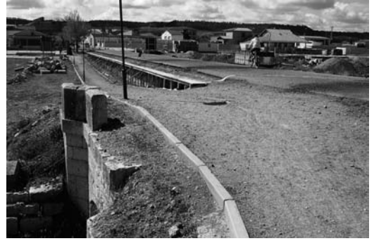
Figura 6 El Puente de Renedo en 2009, cuando se desmontó el pretil para comenzar las obras del ensanche de la plataforma
