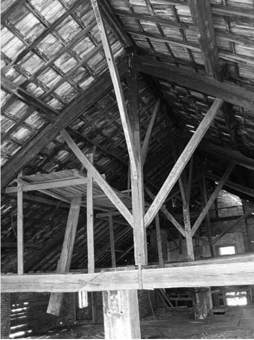
Figura 3 Interior del edificio principal del aserradero
