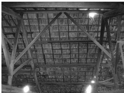
Figura 5 Organización transversal de la cubierta
