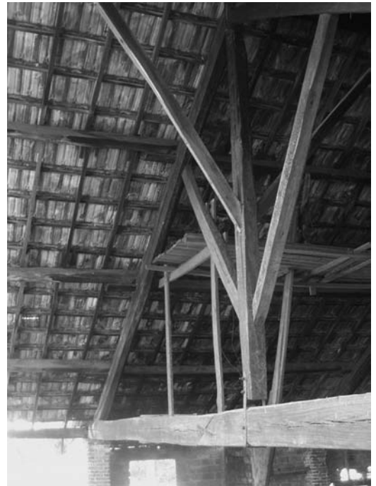
Figura 4 Pendolón con las dos parejas de tornapuntas
