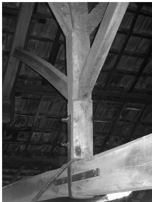
Figura 6 Ensamblés de la cercha nº 4
