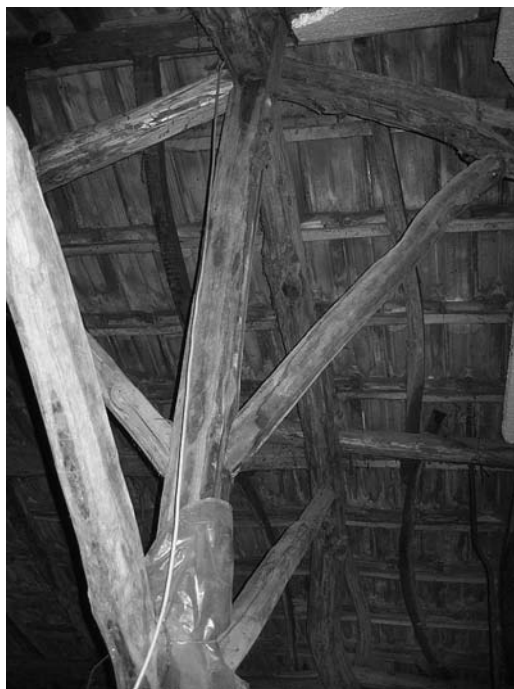
Figura 8 Detalle del pendolón de la cubierta
