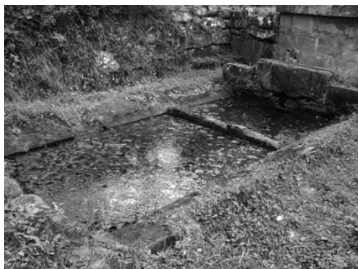
Figura 5 El lavadero de Repudio (Valderredible, Cantabria, ca. 1890), asociado a una fuente, consiste en un depósito de planta rectangular construido a cota de suelo. Tiene doble pila y está realizado íntegramente en piedra de sillería, con refregaderos inclinados y de superficie lisa. El agua llega de la fuente conducida por un canal descubierto e ingresa en el lavadero mediante un orificio en uno de los muros, desagua por reboso y el caudal discurre libremente hasta un riachuelo
