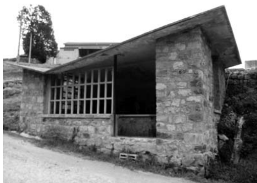
Figura 15 Lavadero de Santiurde (Santiurde de Reinosa, Cantabria, ca. 1965). Comparte manantial con una fuente y abrevadero, de construcción anterior, el agua llega desde el abrevadero a través de un caño cerámico que mana ininterrumpidamente
