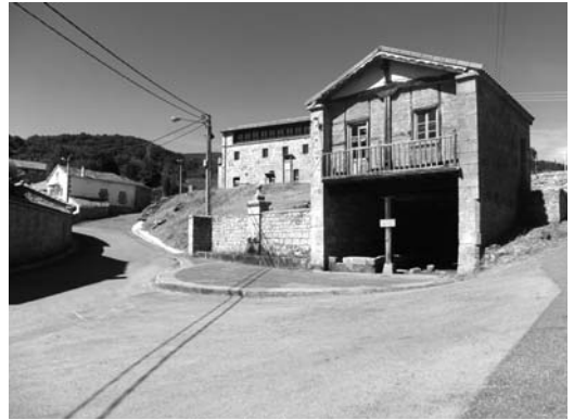
Figura 13 Lavadero de Corconte (Campóo de Yuso, Cantabria, ca. 1895). Recibe el agua directamente desde el manantial, mediante un caño en el frente, y el caudal sobrante del abrevadero contiguo
