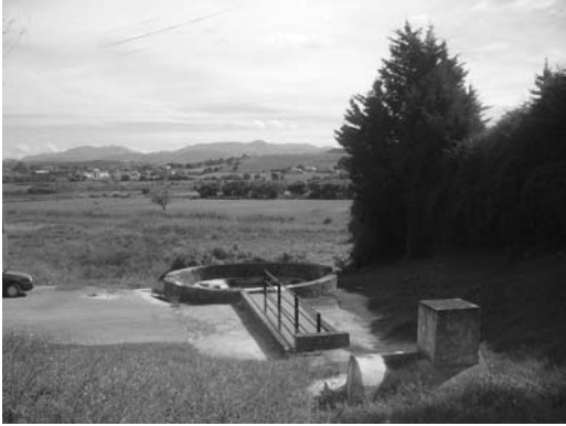
Figura 3 Conjunto hidráulico en disposición lineal de Via (Marina de Cudeyo, Cantabria), acomodado a la topografía del terreno. La infrecuente planta circular del lavadero está protegida por un muro concéntrico que resguarda este depósito del ganado en el abrevadero
