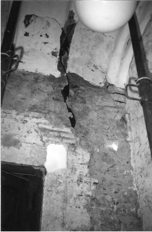
Figura 11 Encuentro entre el forjado y las paredes del pabellón de la vivienda en reparación. (Ajuntament de Barcelona)
