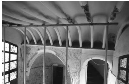
Figura 10 Edificio de conserjería. Forjado en reparación (1996). (Ajuntament de Barcelona)
