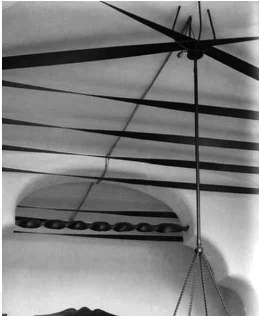
Figura 5 Interior de la Torre de Bellesguard. (Cátedra Gaudí)
