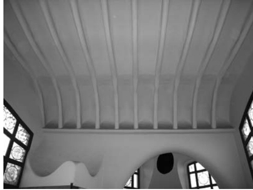
Figura 9 Edificio de conserjería. Vista actual del forjado. (Elaboración propia)
