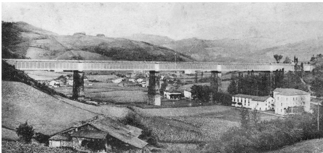
Figura 2 El Viaducto de Ormaiztegi. (Diputación de Gipuzkoa)
