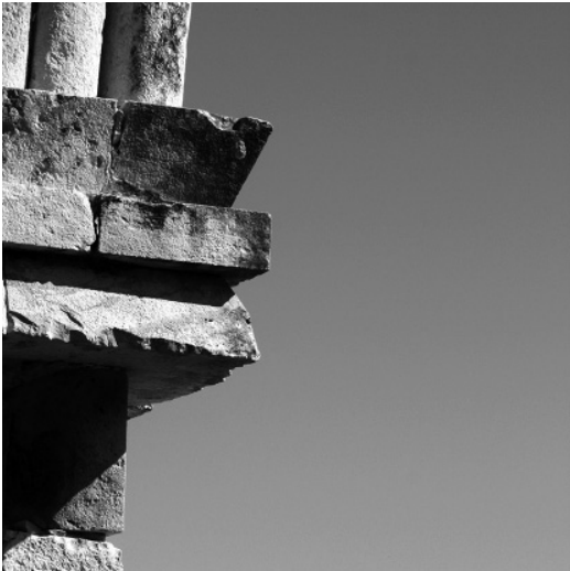
Figura 12 Detalle de la cornisa media de la Casa de las Tortugas de Uxmal (Yucatán). Fotografía de G. Muñoz.
