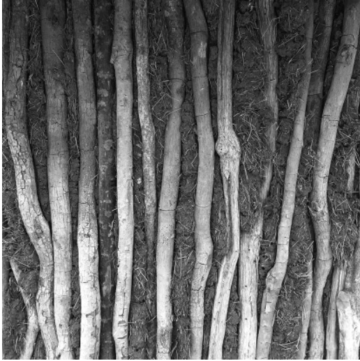
Figura 4 Detalle de un muro de bajareque.
