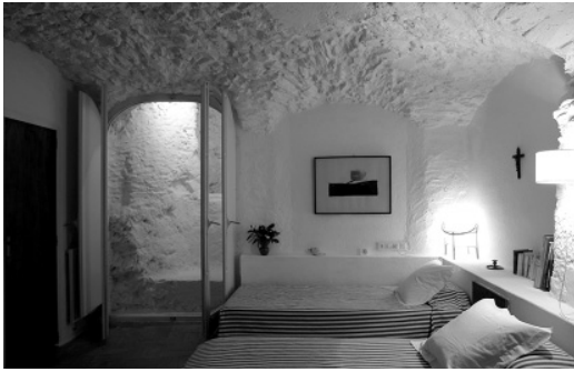
Figura 7 Bóveda de mampostería de piedra BP2 en planta baja; al fondo el pozo de la fachada posterior a través del que ventila e ilumina la habitación con la solución dada por Coderch. Fotografía Ana Rodríguez García.
