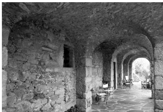
Figura 10 Bóveda de mampostería de piedra BP5 en la galería de planta baja. Fotografía Ana Rodríguez García.
