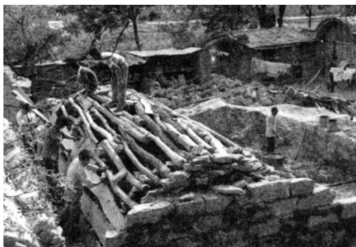
Figura 12 Construcción en mayo de 1998 de bóveda sobre encofrado parcial de tierra con cimbra auxiliar (técnica 2) en viviendas yaodong , en Yanchuan, provincia de Shaanxi en la Meseta de Loess, China (Bodolec 2005)
