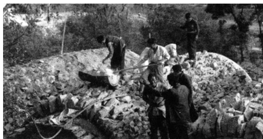
Figura 13 Construcción en mayo de 1998 de bóveda con técnicas 1 y 2. En ambos casos, sobre una capa de barro de ejecución cuidada, se coloca la piedra que conforma el intradós de la bóveda y se vierte una mezcla muy líquida de cal y tierra. Viviendas yaodong , en Yanchuan, provincia de Shaanxi en la Meseta de Loess, China (Bodolec 2005)
