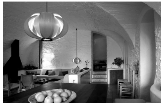
Figura 8 Bóveda de mampostería de piedra BP4 en planta baja, construida con molde de cañizo sobre encofrado de tierra. Fotografía Ana Rodríguez García.
