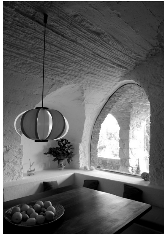
Figura 9 Bóveda de mampostería de piedra BP4 en planta baja, construida con molde de cañizo sobre encofrado de tierra. La marca de la caña se aprecia con claridad hasta la un tercio de la bóveda, cambiando después a tabla de madera. Fotografía Ana Rodríguez García.
