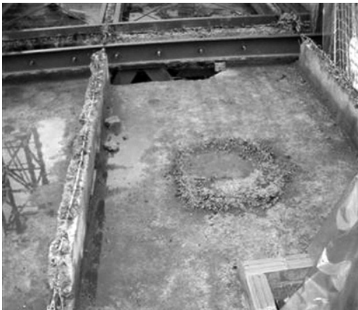
Figura 14 Fotografía tomada en la rehabilitación de los forjados de la Alhóndiga de Bilbao. Montón de grava sobre losa inferior. Fuente: Iñaki Marcos.
