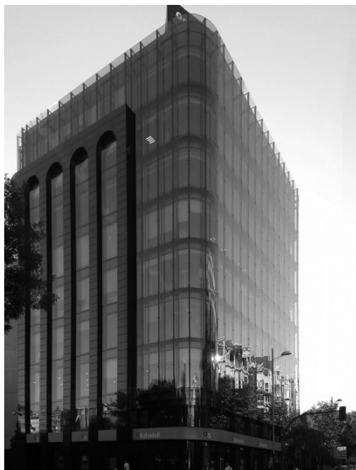
Figura 9 Edificio Revilla. Vista de las fachadas Norte y Este. Foto de los autores (2016).
