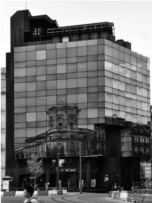
Figura 3 Edificio Bankuni3n. Vista de las fachadas Sureste y Suroeste. Foto de CP Arquitectos (2015). Cortesía de R. del Campo.
