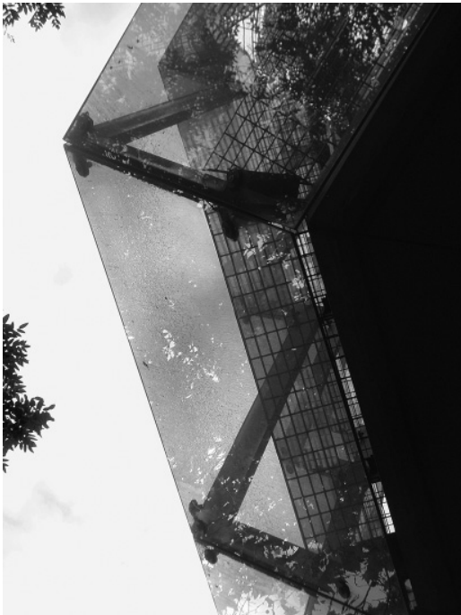
Figura 2 Edificio Miguel Ángel 11. Arranque inferior de la fachada de doble piel. Foto de G. Souto-Blázquez (2012).
