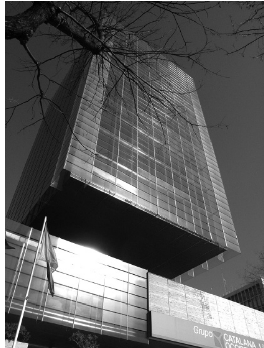
Figura 5 Edificio Castelar. Vista del volumen de la torre en voladizo sobre el cuerpo inferior. Foto de G. Souto-Blázquez (2009).
