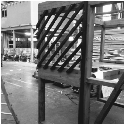
Figura 6. Sección de la torre de acceso a las Galerías Punta Begoña, pre-montada en los talleres de ZURTEK. Fuente: Ander de la Fuente
