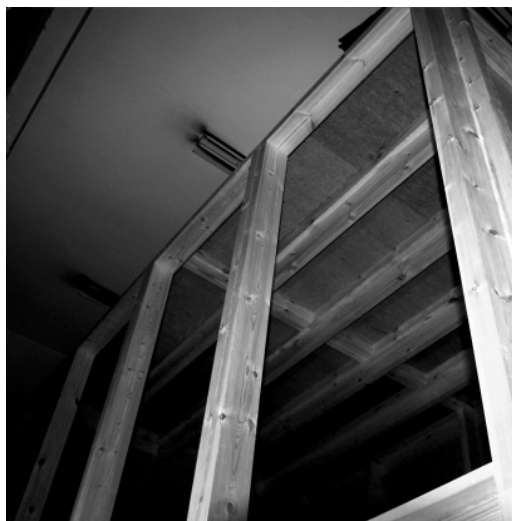
Figura 9. Espacio acondicionado con el sistema MATRYOSHKA©, como una caja habitada dentro de un edificio patrimonial sin condiciones para su uso actual (antiguo cuartel de bomberos en Trapagaran, Bizkaia, en proceso de obra). Fuente: Víctor Araújo
