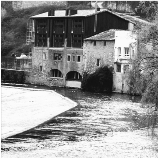
Figura 11. Edificio para albergue de peregrinos en el Camino de Santiago construido con el sistema MATRYOSHKKA ® dentro de otro (antigua tenería en la calle de Curtidores de Estella-Lizarrá, Navarra), del que se conserva su estructura preexistente sin someterlo a procesos de vaciado o fachadismo. Fuente: Jose Antonio Sanz
