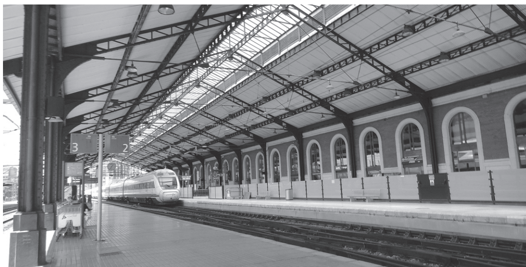
Figura 2 Marquesina de la Estación del Norte de Valladolid (Autoras 2015)
