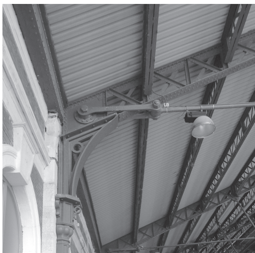
Figura 8 Estación de Medina del Campo (Autoras 2015)
