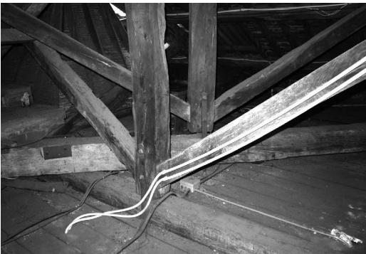
Figura 11 Solución del encuentro de los faldones con dos cuchillos cruzados en el edificio de Intendencia del Arsenal de Ferrol. (fotografía el autor)
