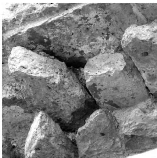
Figura 7 Dettaglio della cornice con i denti di sega posta sopra l'architrave del portale: i mattoni di recupero sono tagliati a forma di prisma e sagomati con un lato aguzzo
