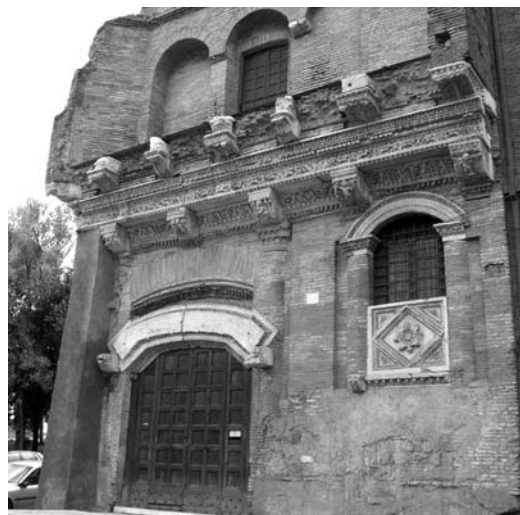
Figura 1 Prospetto principale della Casa dei Crescenzi in Roma
